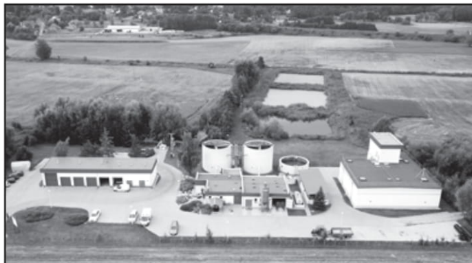
Oczyszczalnia ścieków w Grotnikach
