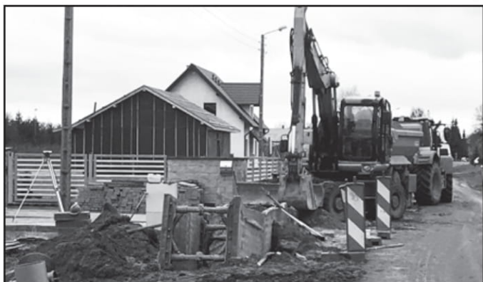
Budowa sieci kanalizacji sanitarnej na ulicy Szkolnej w Krzycuku Wielkim
