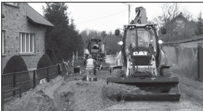
Budowa sieci kanalizacji sanitarnej na ulicy Leśnej w Dłużynie
