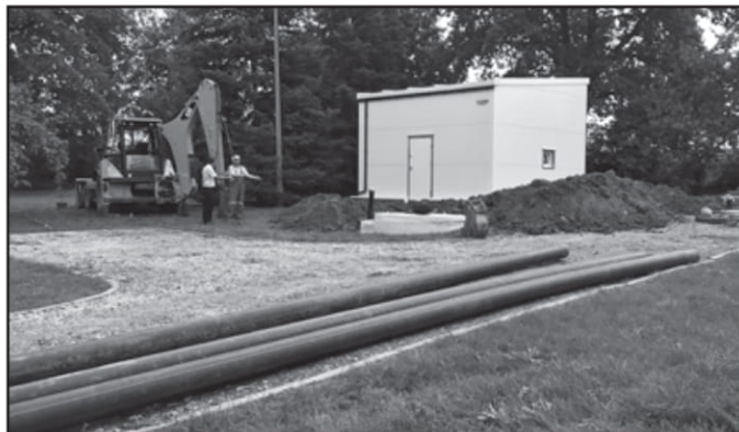
Roboty modernizacyjne na stacji uzdatniania wody we Włoszakowicach
